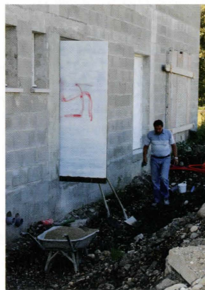
Le centre culturel turc de la Côte-Saint-André (Isère) vandalisé à peine construit.
